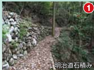
明治道のところどころには、見事な石積みが残ります。
