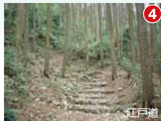
段端だけ石を並べた石段ですが、排水のためや、草鞋を洗うために使われたといわれる洗い越しが数ヶ所に残っています。
